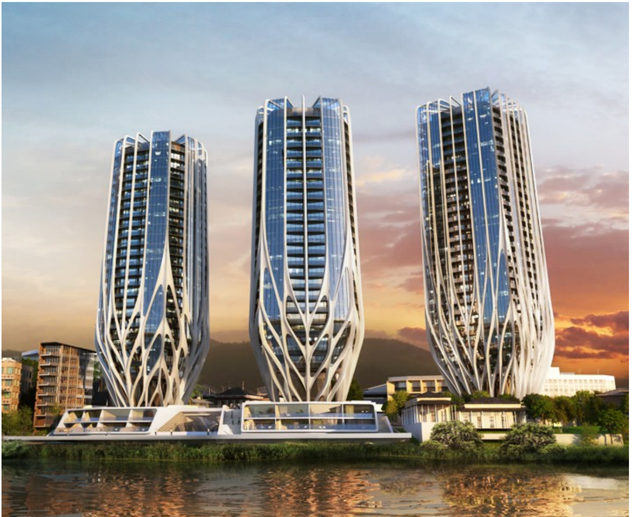
Архитекторы Заха Хадид представили трио «Цветущих» жилых башен на набережной Брисбена
